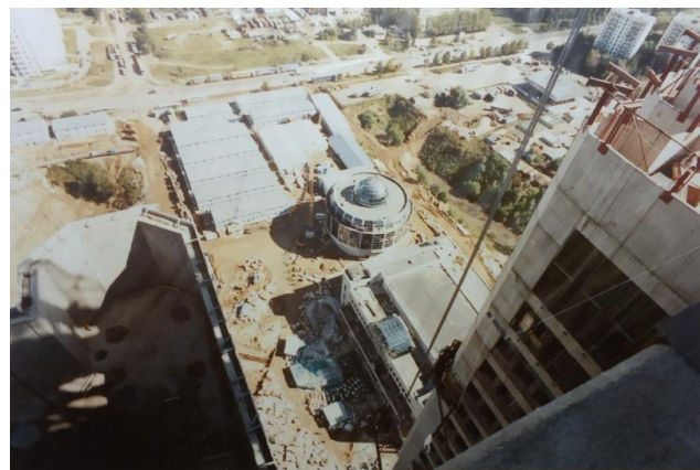
Рисунок 2 - ...в процессе строительства
