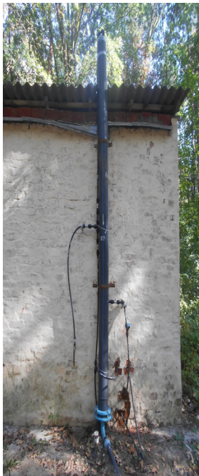
Рис. 7. Лабораторная установка обезжелезивания подземных вод биологическим методом (блок А – БР с волокнистым загрузкой)
